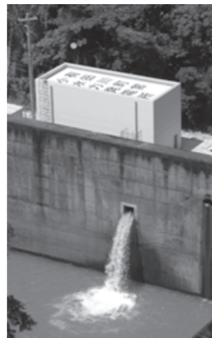
有田川町宮二川小水力発電所 【県営二川ダム維持放流水を利用】
