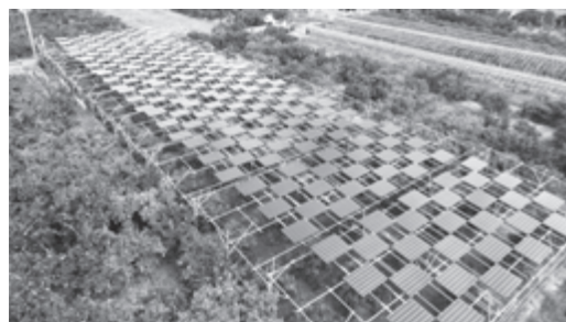
エネルギー兼業農家として みかん畑の上に併設されている太陽光発電設備
