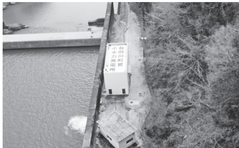
有田川町が二川ダムに設置した小水力発電所は、日本初の試みとして高く評価されている
