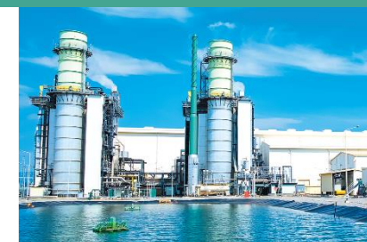
排ガス浄化装置の省エネ
